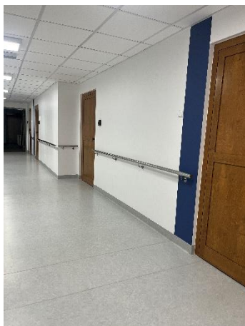
Zdjęcie nr 7: Pochwyty w ciągach komunikacyjnych
