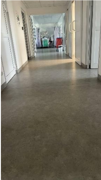
Zdjęcie nr 1: Montaż wykładziny PCV antypoślizgowej i pochwyków ściennych
